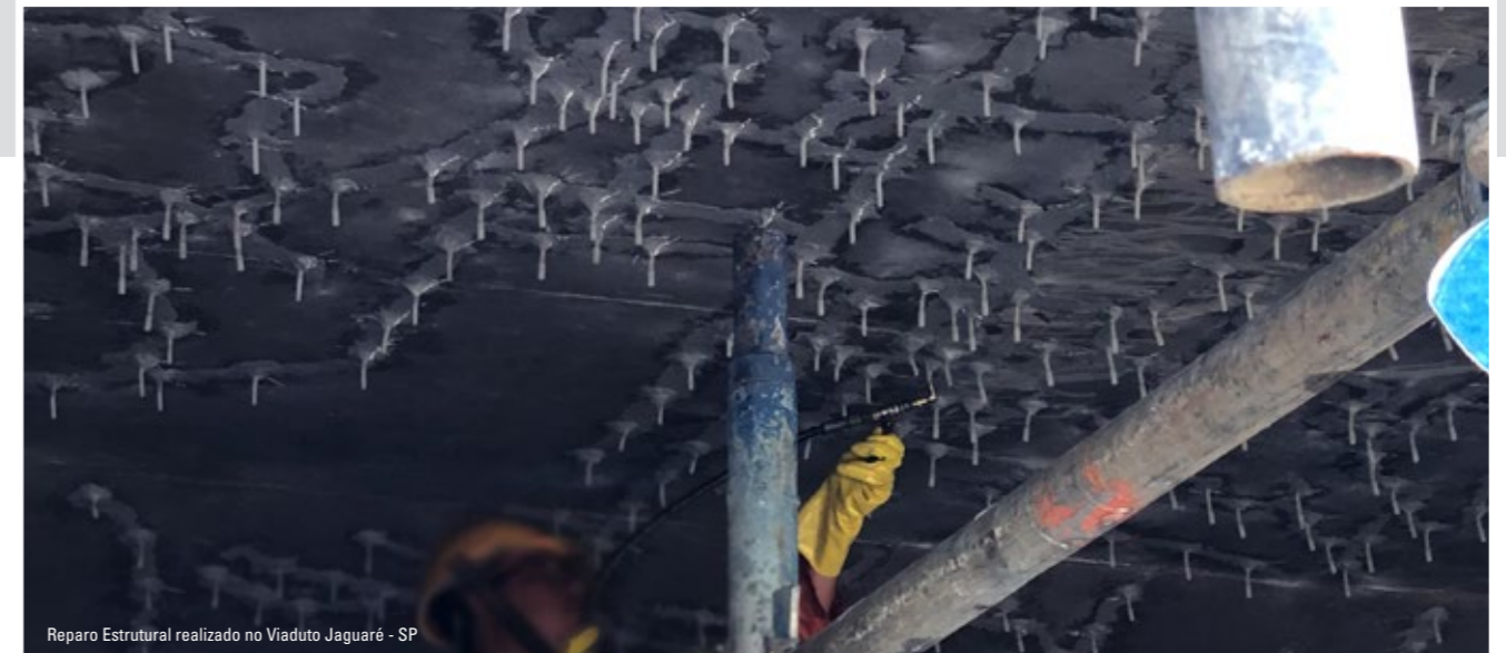
Reparo Estrutural realizado no Viaduto Jaguaré - SP
