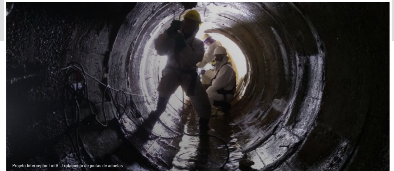
Projeto Interceptor Tietê - Tratamento de juntas de aduelas
